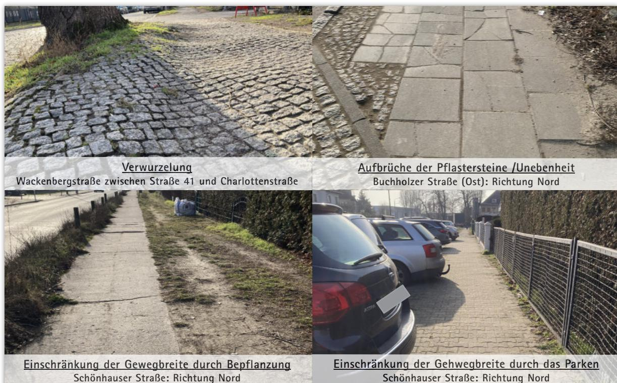
Abbildung 3-15 Beschädigungen bzw. Einschränkungen auf den Gehwegen
