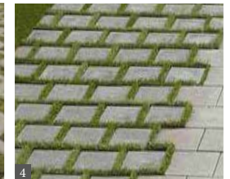
4 Bei wasserdurchlässigen Pflastersystemen werden Niederschläge direkt von der Fläche aufgenommen. Die Einleitung in die Kanalisation entfällt. Fotos: Umwelt- und Naturschutzamt Panikow (1+3), stock.adobe.com (2), privat (4)
