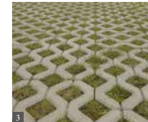
3 Rasengittersteine aus Beton oder wahlweise auch aus Kunststoff mit wabenförmigen Zwischenräumen sind eine Alternative zu gepflasterten oder betonierten Flächen.
