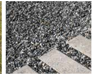
2 Bei einer Kies-Splittdecke besteht die Deckschicht aus ungebundenen runderkörnigen oder gebrochenen Mineralstoffen, die eine gleichförmige Körnung aufweisen.
